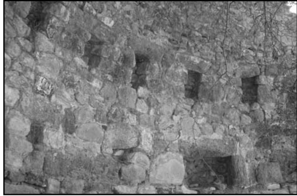
Resim 11: Hamamın (?) tonozlu 3st 3rt3s3
